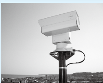
▲高萩中学校屋上に設置した津波監視カメラ
