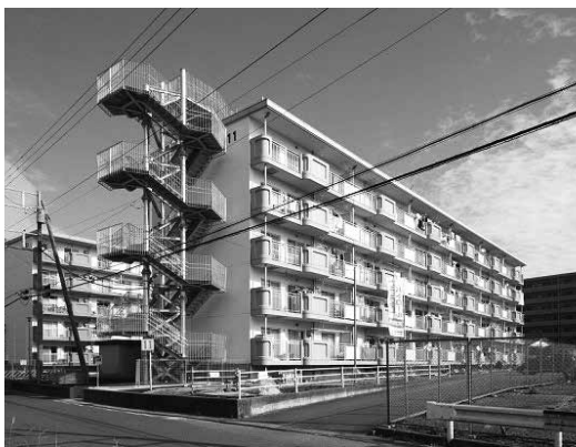
高浜市営住宅
