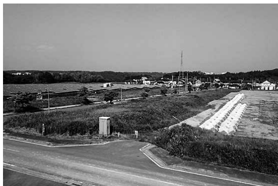
グリーンタウンつな 消波ブロックヤードと太陽光発電施設
