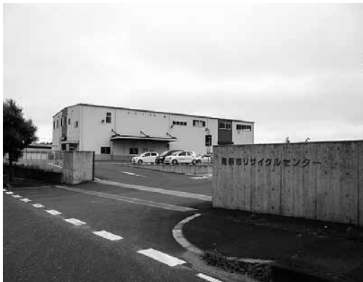
高萩市リサイクルセンター
