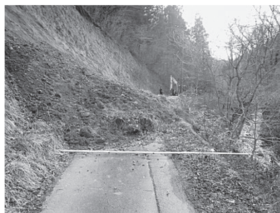
市道4023号線(横川)法面崩壊箇所
