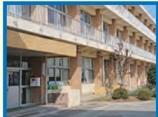
高萩小学校 南校舎1階昇降口
