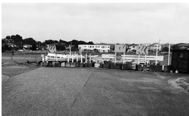
工事が止まっている 都市計画道路3・4・1号
