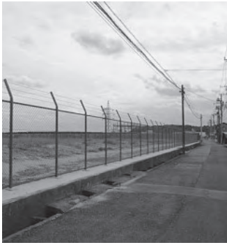
改修した高萩協同病院跡地のフェンス
