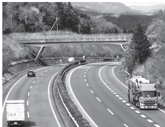
高速道路を跨ぐ和野橋
