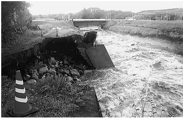
台風 19 号による被害（花貫川・秋山地内）
