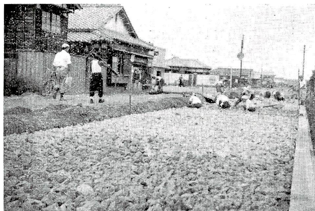
新国道コンクリート舗装工事状況
