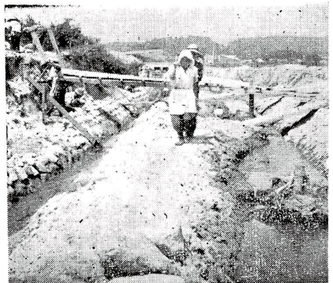
谷地川改修工事現場
