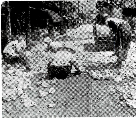
昭和通り舗装工事現場
