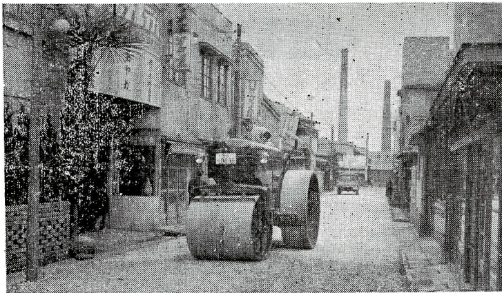
道路の舗装工事進む
