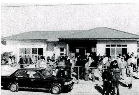
完成した石滝公民館
