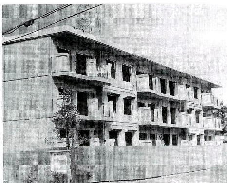
▲建設中の市営住宅
