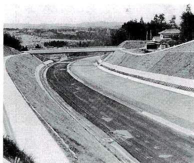
▲建設が進む常磐自動車道
