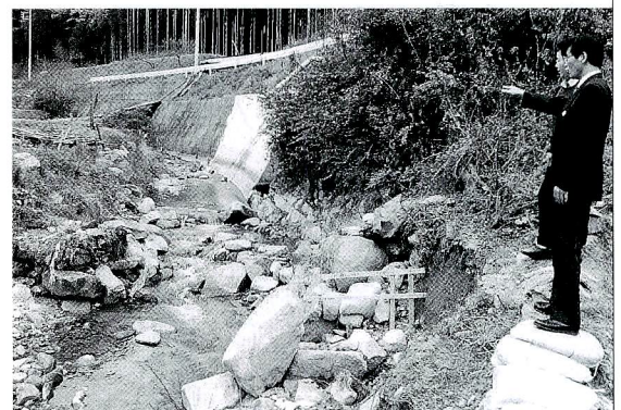
台風17号の被害を受けた福平の桃源地区の河川。国の予算が付き、護岸工事と流されて崩れた堰の改修が、これから行われます。
