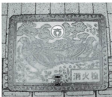
消火栓の鉄製ふた
