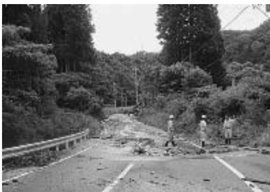
7月15日の台風第4号により土砂災害の被害を受けた大字上手網地内の道路
