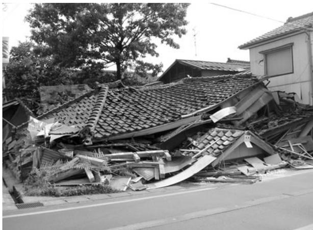
平成18年7月16日新潟県中越沖地震で倒壊した木造家屋
