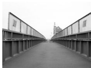
開通した新橋
