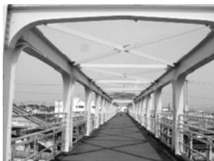
撤去した旧橋
