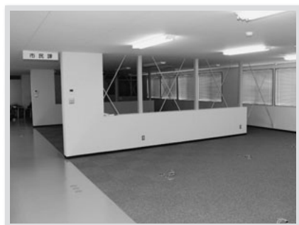
A 棟 1F 内部
