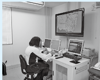
▲市役所の遠隔操作室
