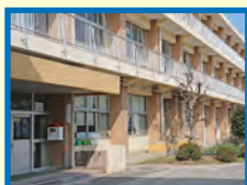
高萩小学校 南校舎1階昇降口
