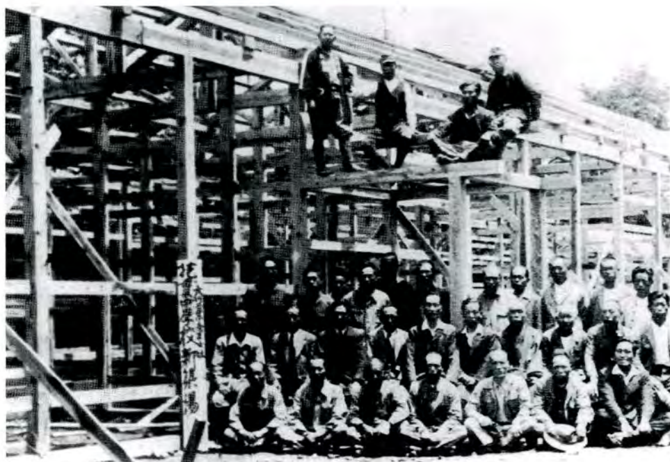
花貫中学校新築工事 昭和23年(1948)撮影▶
