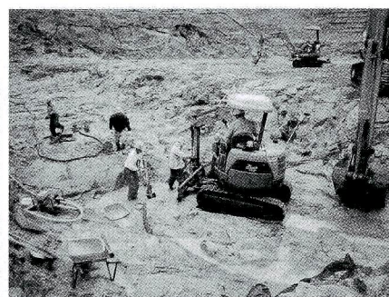
①基礎工事(岩盤清掃)
