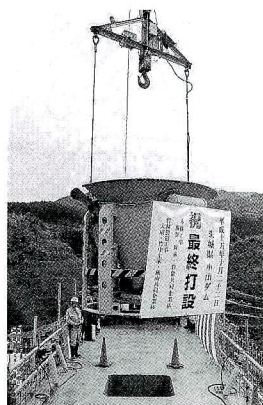
④最終打設
