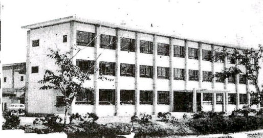
●市庁舎＝市政の殿堂市庁舎は昭和33年8月竣工、8階建の鉄筋コンクリート造、668坪、総工費4754万円
