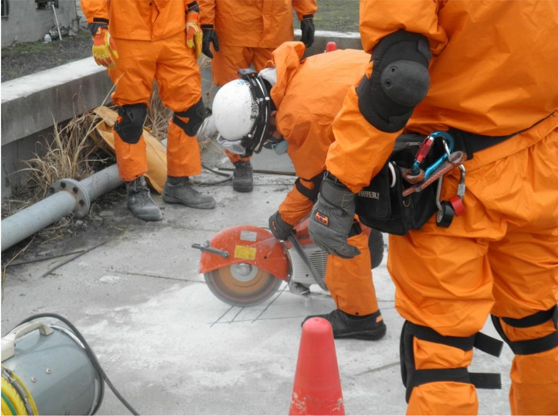
ダイヤモンドブレードを使用して、はつり（打撃・破碎）を容易にするために切込みを入れる。
