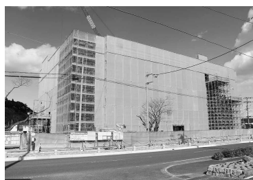
本庁舎災害復旧・本 庁舎各種設備移設等 事業 11億6,332万円 新庁舎建設、備品購入、各 種設備移設、仮設庁舎解体 等にかかる経費
