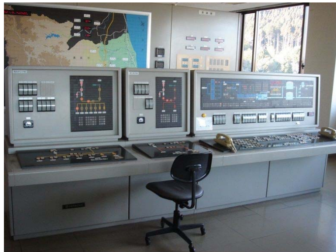
中央監視装置
