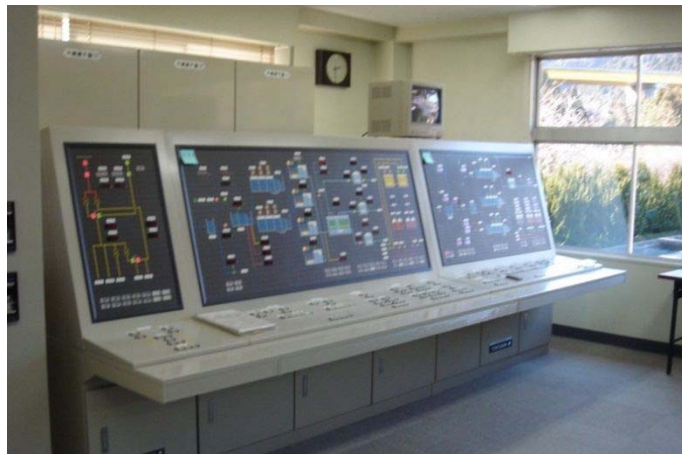
中央監視装置
