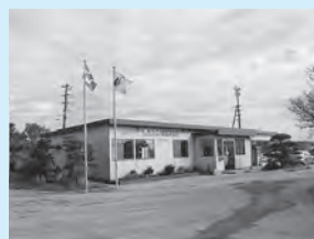
日本原料株式会社 高萩工場 住 所：高萩市安良川259-1 T E L：0293-22-2695
