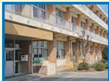
高萩小学校 南校舎1階昇降口
