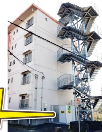
市営高浜住宅 5号棟津波避難階段
