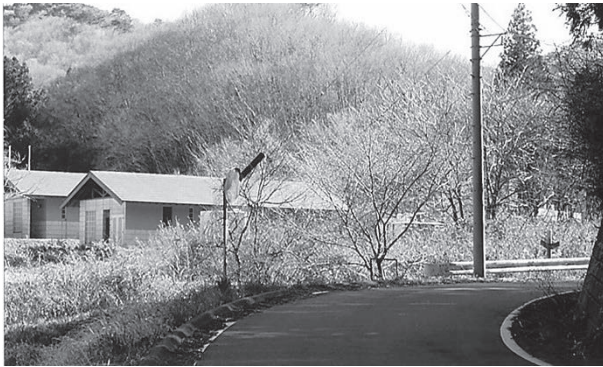
高萩スカウトフィールドに通じる市道104号線道路拡幅整備事業
