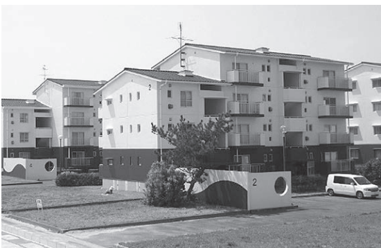
市営花貫住宅
