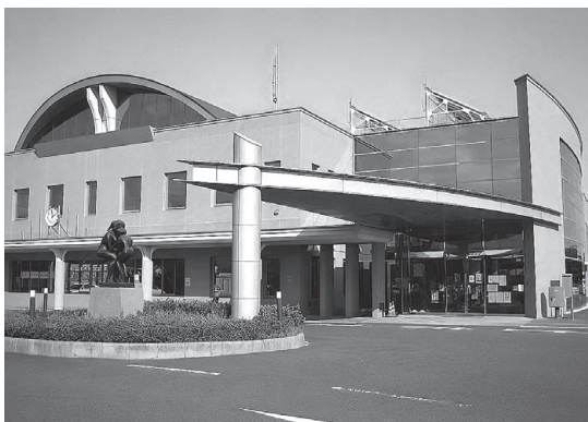
陰圧テント設置予定の総合福祉センター
