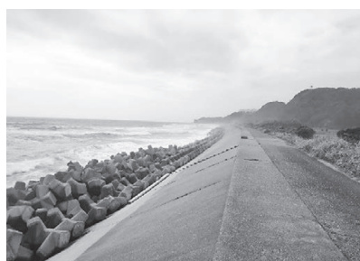
赤浜海岸堤防南側付近
