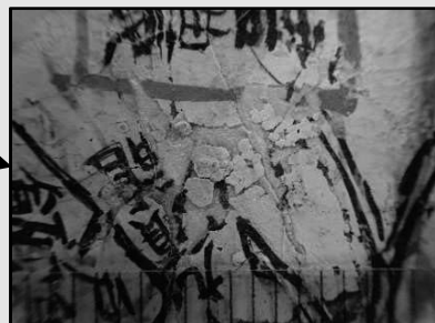
彩色の剥離剥落
