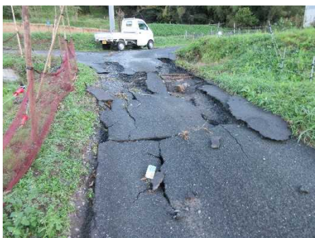
令和元年（2019 年）10 月 台風 19 号 小神戸付近被災状況
