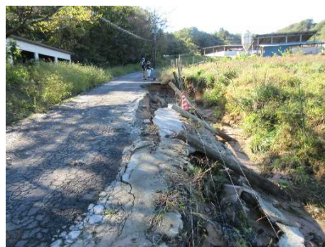
令和元年（2019 年）10 月 台風 19 号 下君田畜産団地付近被災状況
