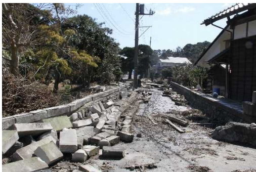
平成 23 年（2011 年）3 月 東日本大震災 高戸付近被災状況
