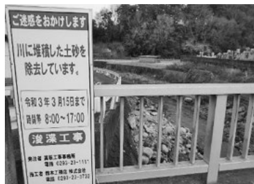
関根前川 堀ノ内橋付近
