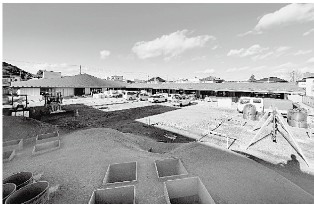
建設中のたかはぎ認定こども園
