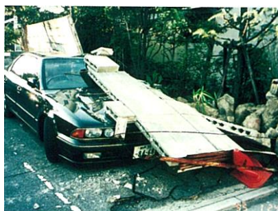
写真 地震時に倒壊したブロック塀
