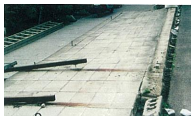
写真 地震時に倒壊したブロック塀
