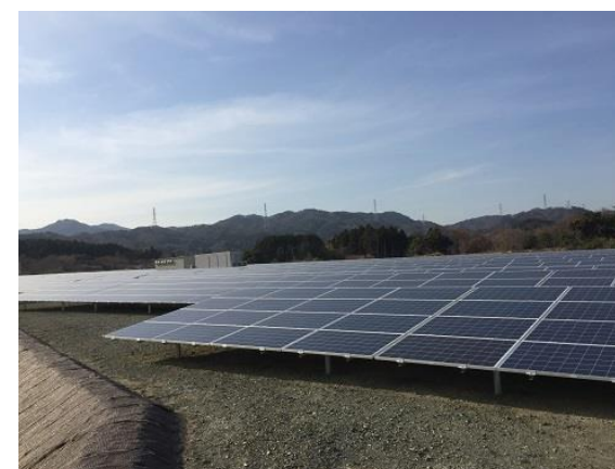
グリーントウンてつな住宅内 太陽光発電の利用
