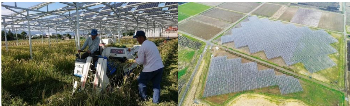
©市民エネルギーちば(株) 匝瑳市 メガソーラー発電所
