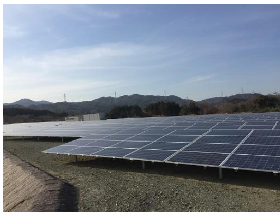
グリーンタウンてつな住宅団地内 太陽光発電施設
