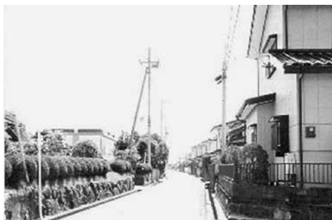
市道1261号線（千代町団地北側）の道路
