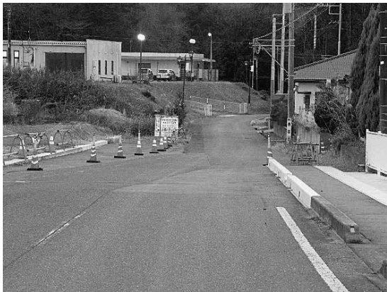
市道217号線道路改良工事
