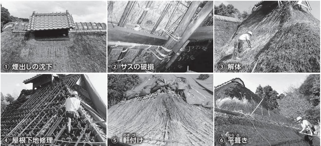
県指定有形文化財「穂積家住宅」は、前回の全面屋根葺替から約20年が経ち、茅の消耗により下地の竹（茅を抑える材料）が表面に現れていました。調査の結果、土間の上部にある「煙出し」を支えている部材（サス）が破損していることも分かりました。
