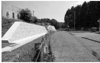
市道217号線 (それいゆ病院入り口付近)
