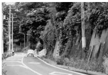
国道461号 八幡宮西入り口 (ガードレール設置要望箇所)
