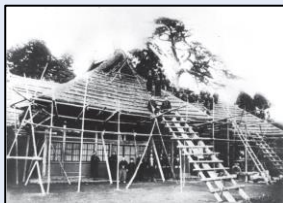
屋根葺替時の様子(昭和7年)
