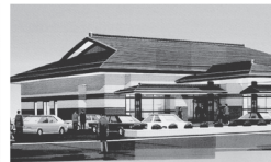
あいばホール 大津会館 北茨城市大津町2670 ☎0293-46-6000
