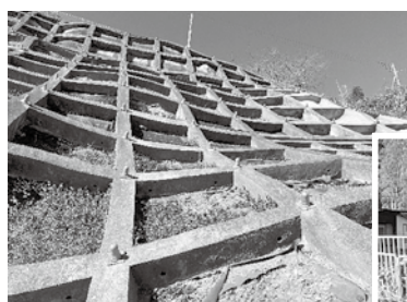
大高寺敷地裏の急傾斜地
