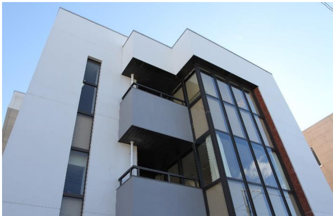
高萩市民センター外観
