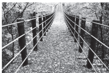
花貫溪谷 汐見滝吊り橋
