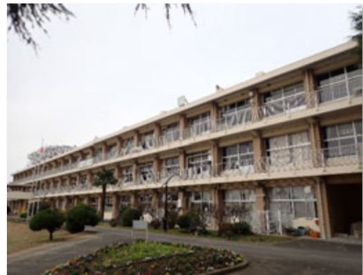
写真3 現在の高萩小学校 校舎
