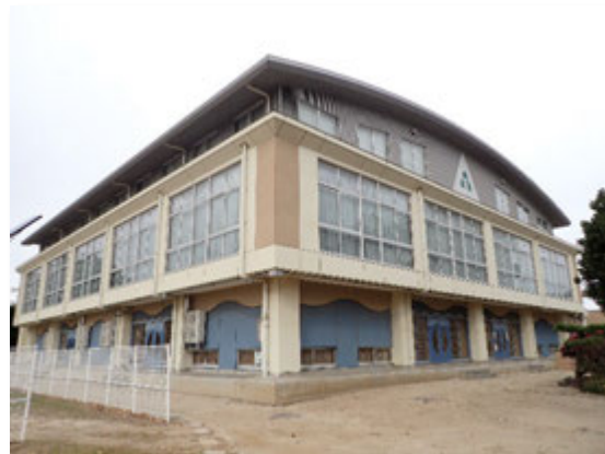
写真4 現在の体育館
